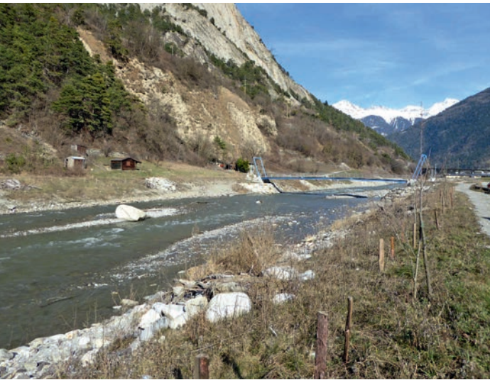
Photo 6: Plusieurs blocs et tas de pierres ont été disposés en pied de rive et dans le lit de la rivière, afin de diversifier les écoulements et la granulométrie du fond du lit. | Foto 6: Mehrere Blöcke und Steinhaufen wurden in das Bett und am Ufer eingefügt, um die Fliessdynamik und die Bettstruktur vielseitiger zu machen.
