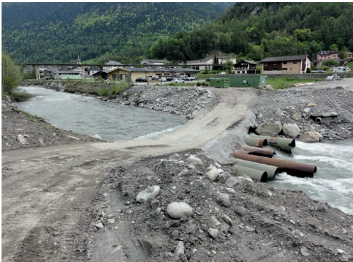
Photo 12: Avant l'ouverture du chantier, un passage à gué a été réalisé, afin de limiter les impacts sur la faune benthique et piscicole, lors des mouvements des véhicules de chantier. | Foto 12: Vor Beginn der Arbeiten wurde eine Furt erstellt, um die Auswirkungen des Baustellenverkehrs auf die Fische und das Benthos gering zu halten.
