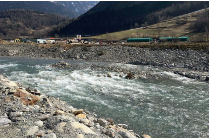
Photo 2: Les seuils infranchissables ont été remplacés par des rampes de fond rugueuses, permettant à la truite fario ( Salmo trutta ) et au chabot ( Cottus gobio ) de facilement remonter la rivière [2016]. | Foto 2: Die Schwellen wurden durch Rampen mit hoher Rauigkeit ersetzt. Forelle und Groppe können ungehindert im Fluss aufsteigen [2016].
