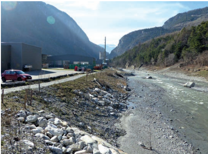
Photo 14: Vision de la Dranse vers l'aval depuis le pont des Illons après la réalisation des travaux. | Foto 14: Ansicht der Dranse in Fließrichtung von der Brücke der «Illons» nach Ausführung der Arbeiten.
