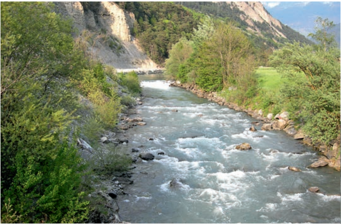
Photo 1: Avant les travaux [2007], plusieurs seuils infranchissables par la faune piscicole étaient présents sur le linéaire, notamment pour les besoins des gravières. | Foto 1: Vor Beginn der Arbeiten [2007], mehrere für Fische unüberwindbare Schwellen charakterisierten den Abschnitt. Zum Teil dienten sie der Kiesgewinnung.
