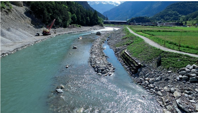
Photo 5: Le grand bras-mort dans la plaine des Trappistes est alimenté en eau par la Dranse et par la nappe. Les hauts-fonds sont clairement visibles. Ces derniers sont délimités de la fosse d’extraction par la mise en place de blocs de grandes tailles. Cette surface se trouve périodiquement sous 20-30 cm d’eau (hautes eaux) et constitue un habitat d’intérêt pour les limicoles. | Foto 5: Der grosse Totarm in der Ebene der «Trappistes» wird aus der Dranse und dem Grundwasser gespeist. Die Untiefen sind gut sichtbar. Sie sind vom Kiesentnahmebereich durch grosse Blöcke getrennt. Dieser Bereich ist regelmässig 20-30 cm unter Wasser (Hochwasser) und ist ein interessantes Habitat für Regenpfeifferartige (Limikolen).
