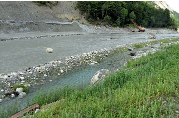
Photo 3: Le bras-mort aval fait plus de 120 mètres de long et est séparé du cours d’eau par une digue, submersible dès Q_5 . Ces déversements permettent également de purger l’aménagement. | Foto 3: Der Totarm ist über 120 m lang. Er ist durch einen überströmbaren Damm vom Bett getrennt. Das ab einem HQ_5 überströmende Wasser spült die Anlage.
