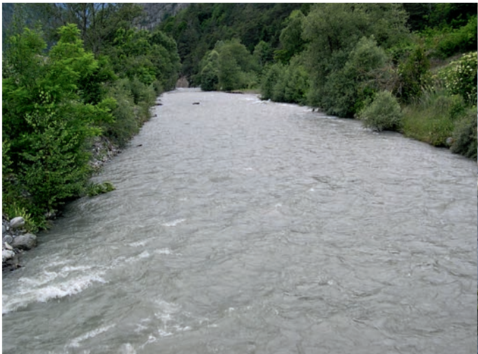
Photo 13: Vision de la Dranse vers l'aval depuis le pont des Illons avant la réalisation des travaux. | Foto 13: Ansicht der Dranse in Fließrichtung von der Brücke der «Illons» vor Ausführung der Arbeiten.
